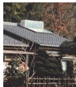
自然循環型太陽熱温水器 従来の温水器
